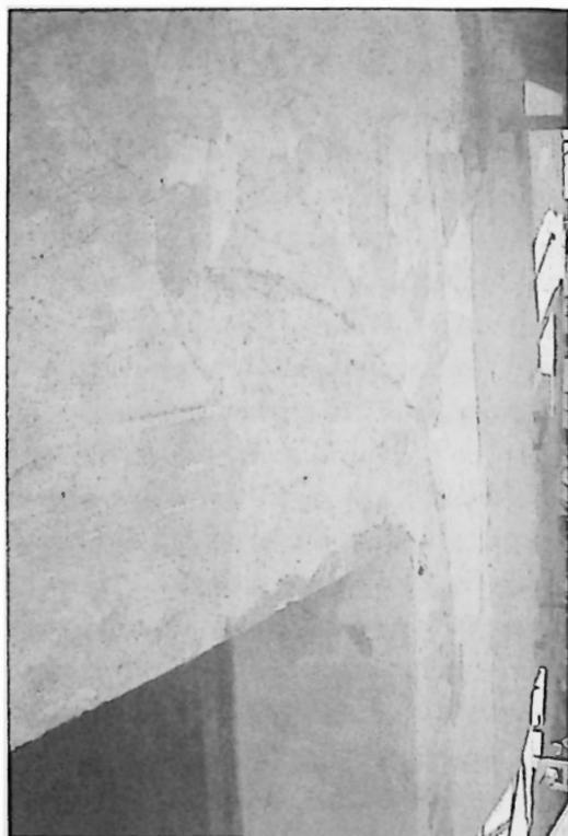
(Fig. 1) *Traccia di una delle arcate componenti il loggiato al piano primo, visibile sul fronte sud. Le arcate furono tamponate (probabilmente nel 500) e successivamente furono realizzate diverse aperture.*
